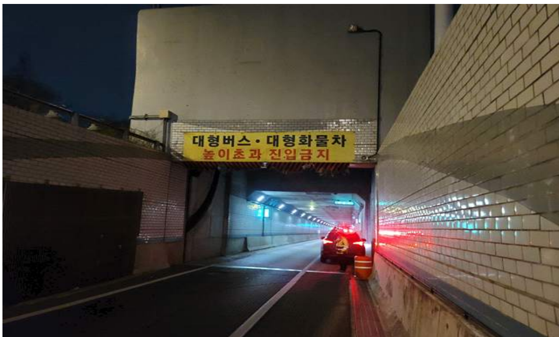
RAMP-D 갱문 진입부 전경
