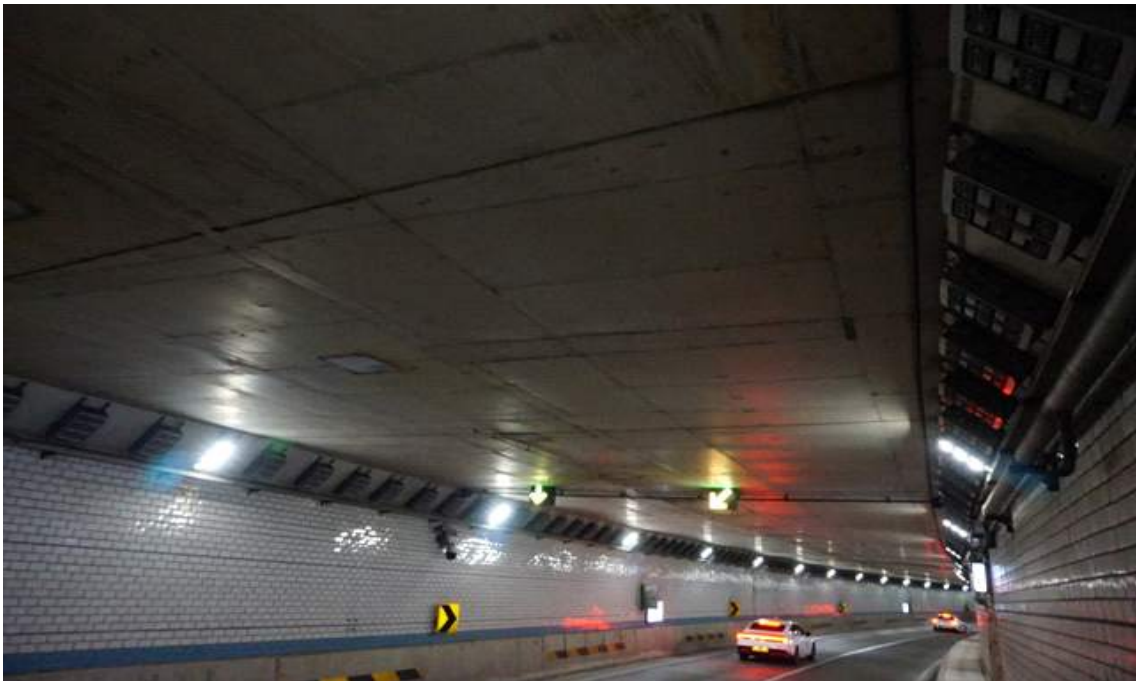
BOX구간 슬래브 전경
